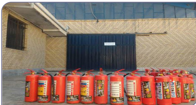
شکل ۵-۹. برخی از خاموش کننده های قابل حمل
