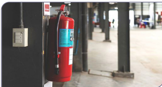
شکل ۹-۳. نصب خاموش کننده در انبار
